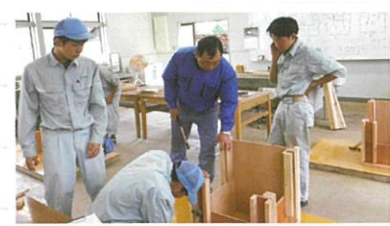
型枠施工
